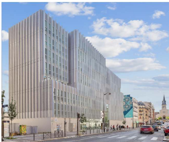
Immeuble Life rue Jeanne d'Arc – Paris (13 ème )
